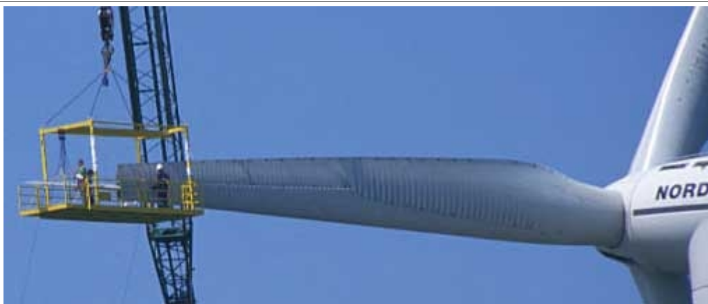
Figur 6 - Rotorbladene er vridd og kan dreies for å øke ytelsen. 5
