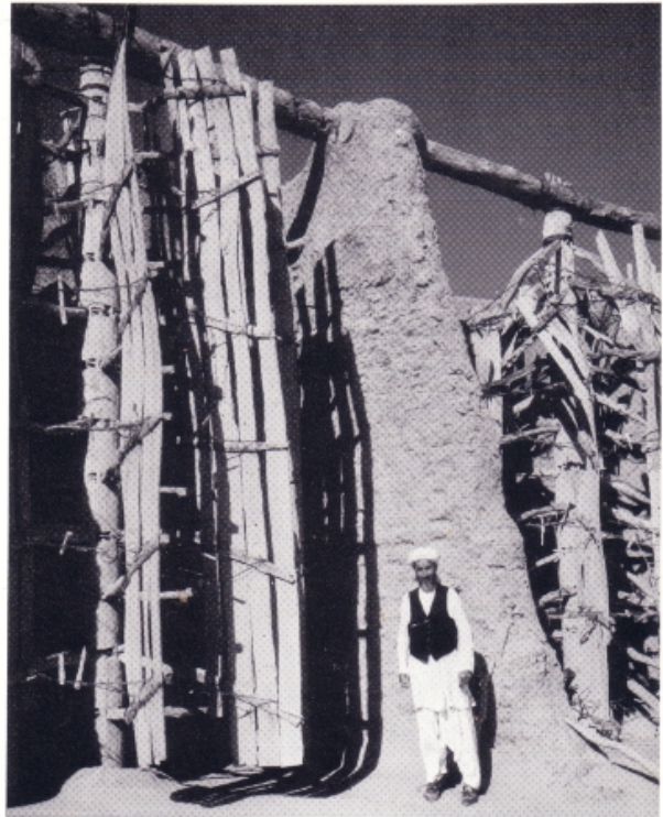
Figur 1 -Mann ved siden av en klassisk persisk vindmølle. Denen typen møller var operative fra rundt år 950 til på 1970-tallet. 1
