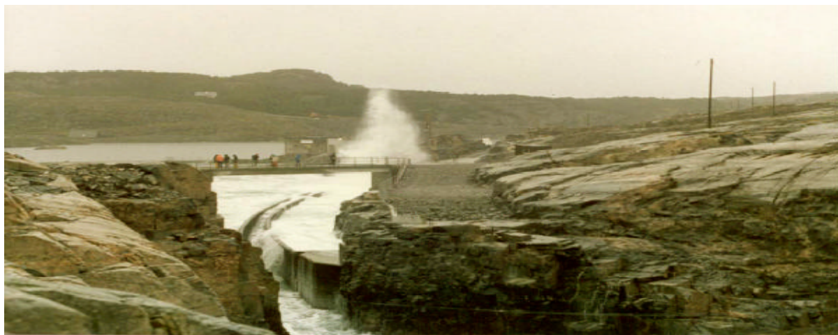
Figur 3.3.2. TAPCHAN ved Toftestallen nær Bergen.
