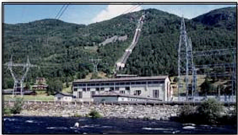
Hol I kraftstasjon i Høvet
