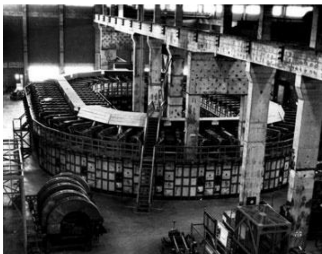
Det racerbaneformede anlegget for elektromagnetisk separasjon.
